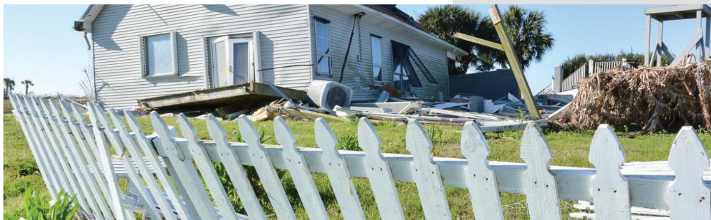
Los efectos de un tornado en una propiedad residencial en Madisonville, Louisiana. El daño a la propiedad representa un reto significativo para los sobrevivientes de desastres catastróficos. Fuente: Sharon Karr
